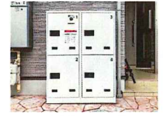
宅配ボックスの設置
